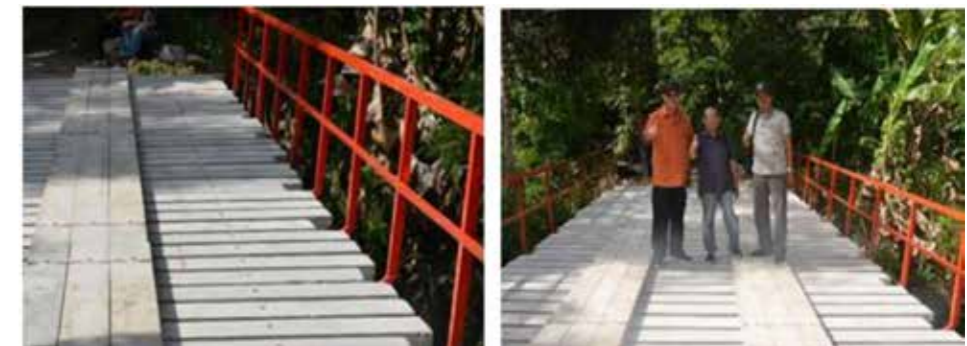
Kondisi setelah papan lantai beton busa selesai terpasang
