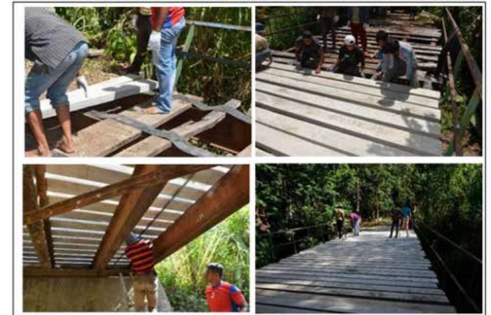
Proses instalasi lantai jembatan
