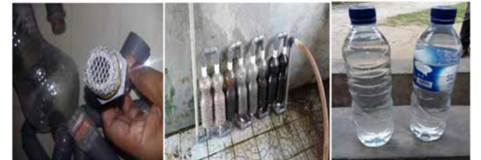
Perakitan, Instalasi Penjernih dan Hasil Air Penjernihan
