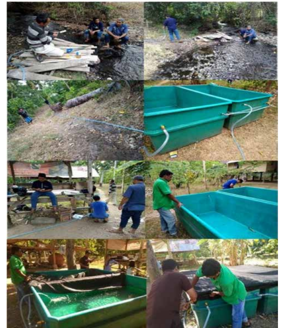
Mulai Budidaya ikan Tilapia di lokasi Mitra Ie Suum (pemasangan instalasi)
